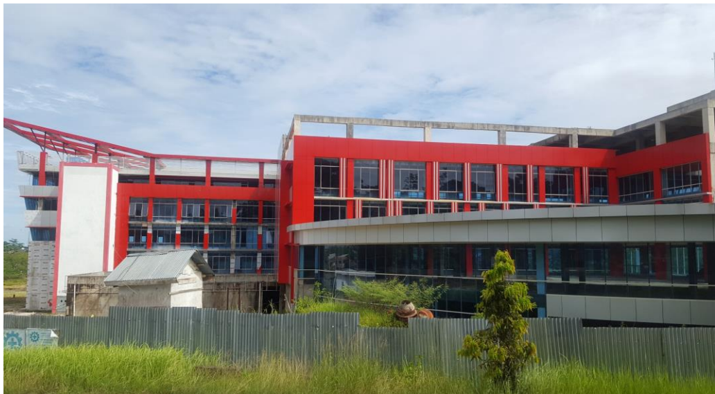
Gambar 3.4 Pembangunan Rumah Sakit Pendidikan (RSP)
