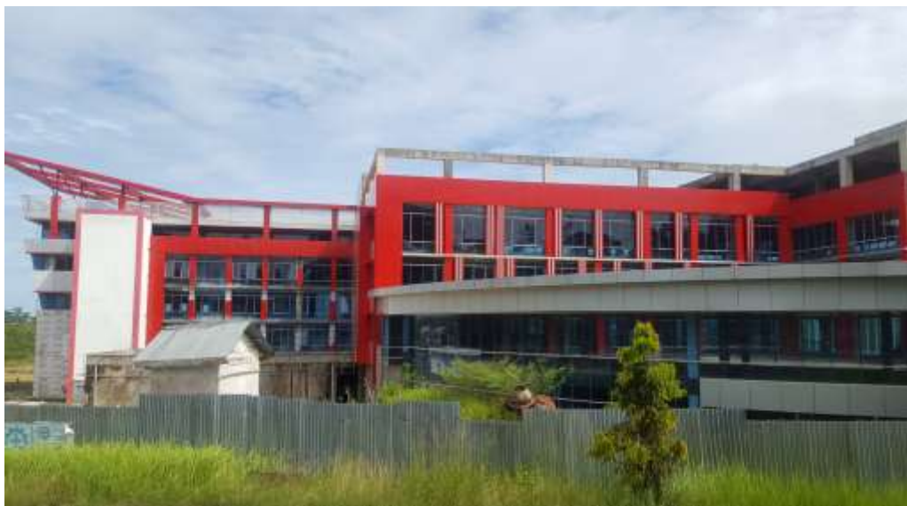
Gambar 4.4 Pembangunan Rumah Sakit Pendidikan (RSP)
