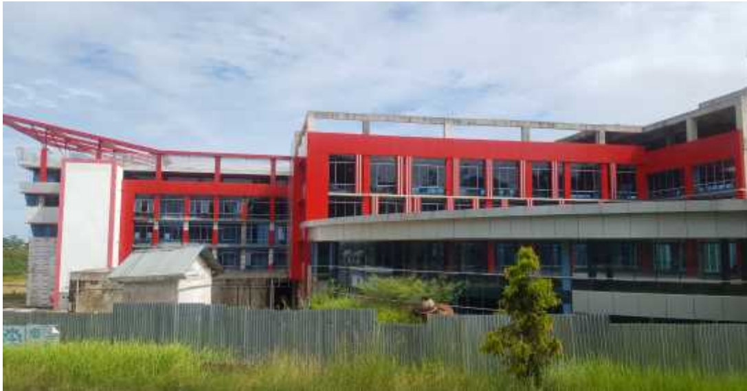
Gambar 4.3. Pembangunan Rumah Sakit Pendidikan
